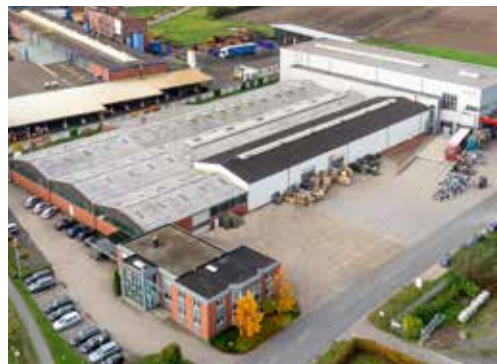
Stabilimento produttivo di Dinklage (Germania)
